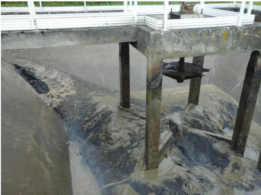
*7 tonnes de dépôts au fond de la station d'épuration*
